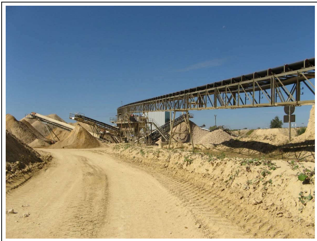
Acheminement des matériaux par bande transporteuse jusqu'à l'installation de traitement primaire et secondaire.
