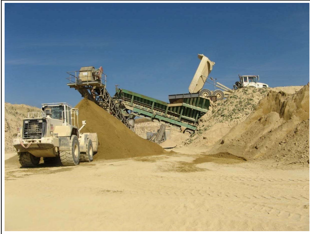
Installation de prétraitement (scalpage) localisée au niveau de la zone d'extraction.
