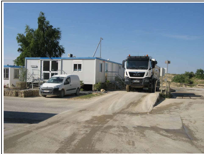
Evacuation des matériaux par camions.
