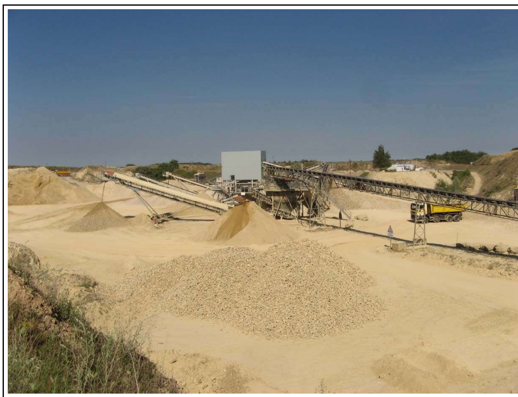
Installation de traitement primaire et secondaire.
