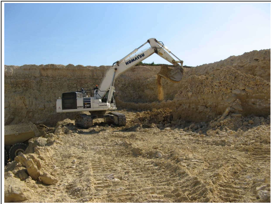
Extraction du gisement à l'aide d'une pelle hydraulique.
